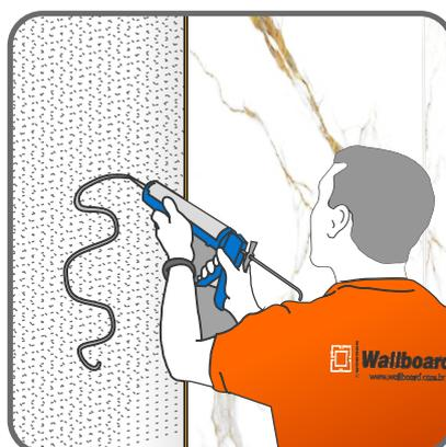
5- Fixa Painel com eficiência, utilize Selante de Poliuretano PU Construção.
