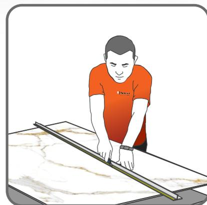
3-Corte pode ser feito com estilete e régua grande com proteção evite retirada da película durante corte.
